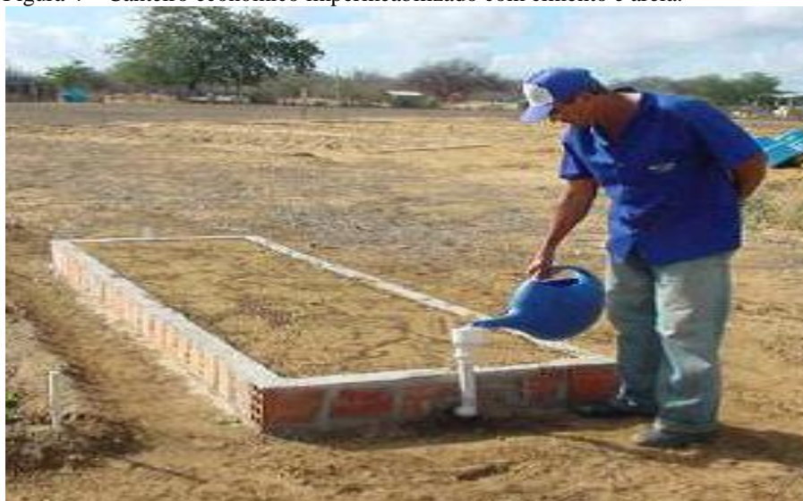
Figura 4 – Canteiro econômico impermeabilizado com cimento e areia.
